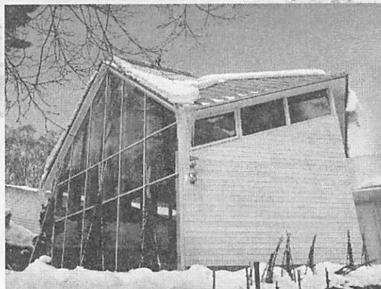
藻岩山中腹駅に隣接した多目的ホール （バードストライクが懸念される大きなガラス窓）
